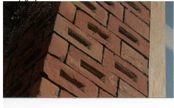
Klamp gelijmd metselwerk
