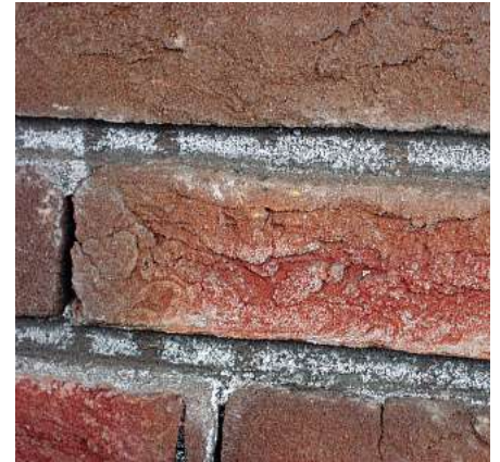
Kalkafzetting in de poriën.
