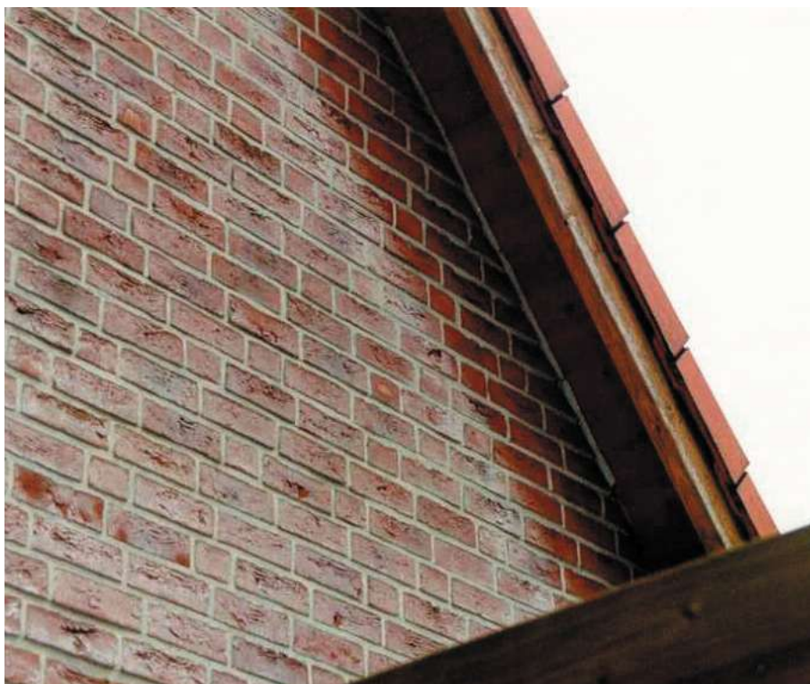
Vergrauwing: kenmerkend is de scherpe begrenzing tussen het beregende en droge deel van de gevel.
